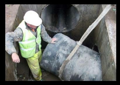
Deslice la válvula en la tubería
